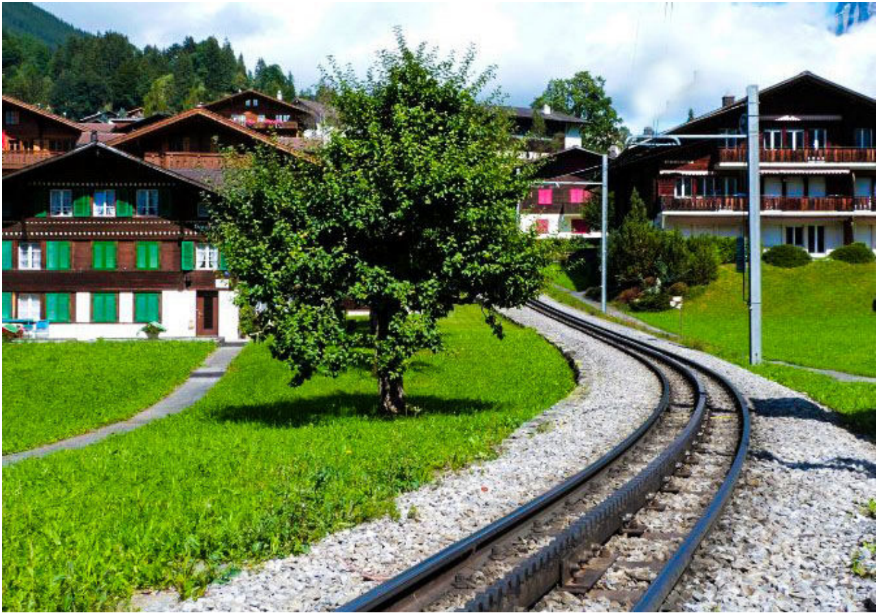
請留意鐵軌中間加了一行"齒軌",這是瑞士特有的登山火車使用的防滑軌道.
